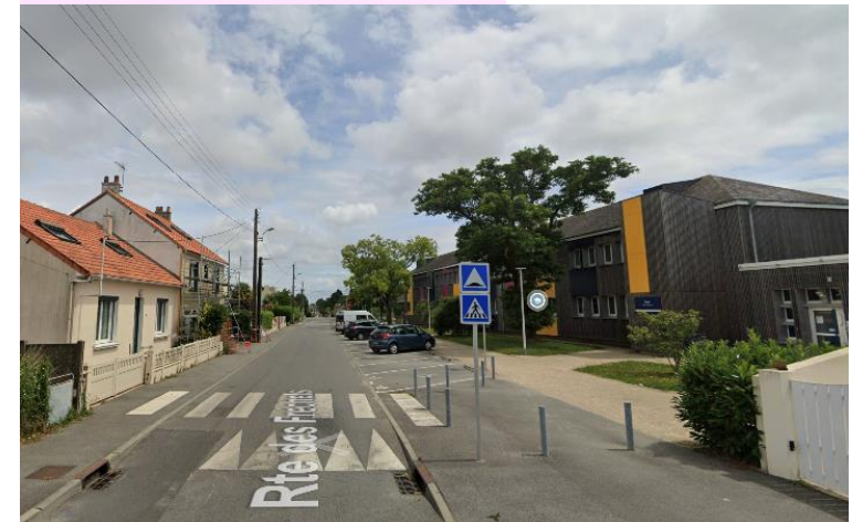
École en zone urbanisée avec un complément d'éclairage public aux abords avec luminaire dédié. École Léon Bloum à Saint-Nazaire.
