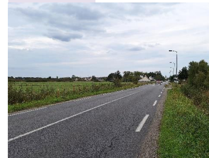
Exemple de route interurbaine entre St-Malo-de-Guersac et Montoir-de-Bretagne
