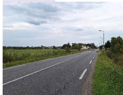
Exemple de route interurbaine entre St-Malo-de-Guersac et Montoir-de-Bretagne
