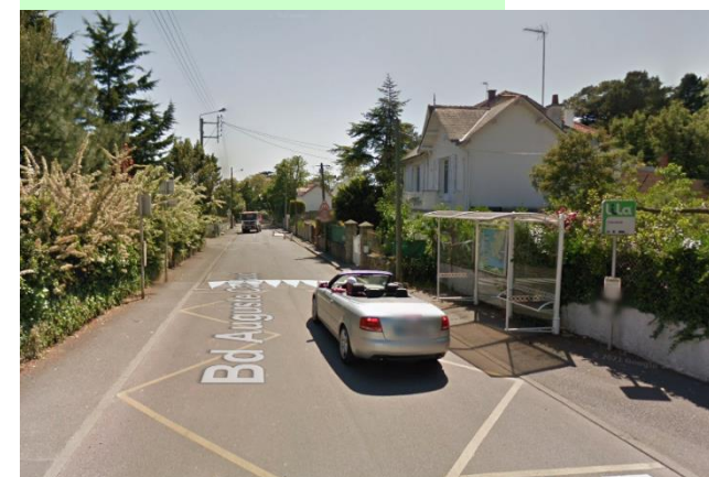
Arrêt de bus en zone urbanisée, éloigné d'un luminaire d'éclairage public pouvant nécessiter une installation dédiée. À La Baule-Escoublac.
