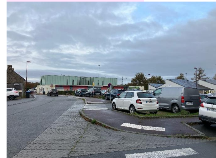
Zone d'équipements publics : abords d'école, centre culturel en face et parking dédié, à Besné
