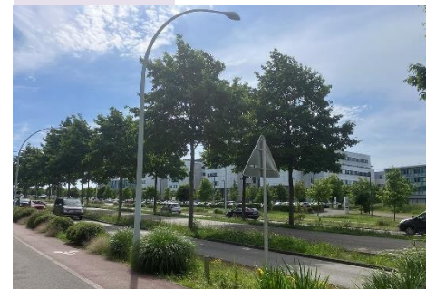
Exemple de voie structurante à Saint-Nazaire (D492/ G. Charpak)
