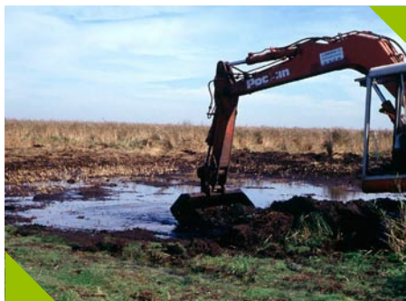
Etrépage à la pelle mécanique
