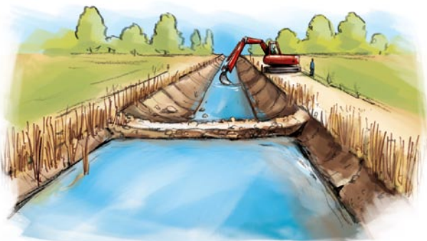
Curage à sec avec mise en place de batardeaux
